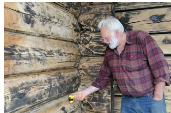
Tømmerveggene i dette huset utenfor Molde er enkelte steder gjennomvåte, og flere steder har de vært angrepet av blomsterbukk.
